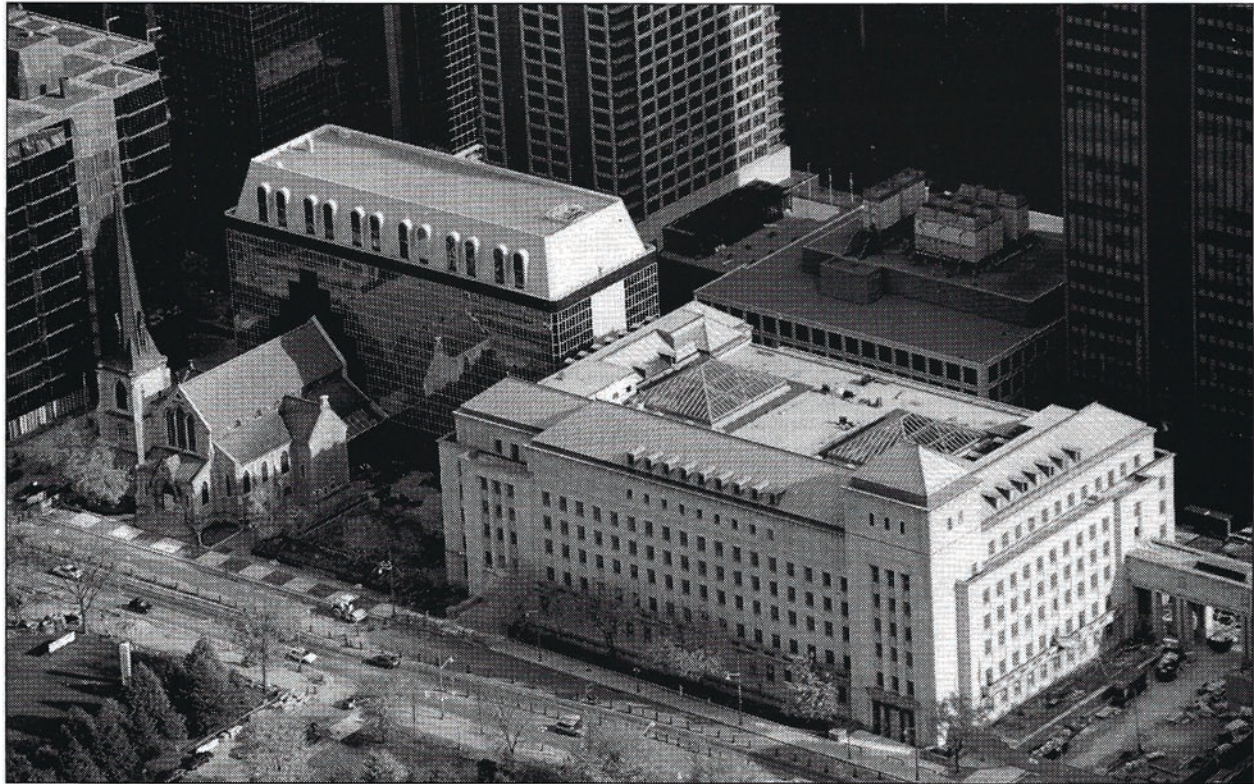
Department of Justice Headquarters L'administration centrale du ministère de la Justice November 16 novembre 1998
